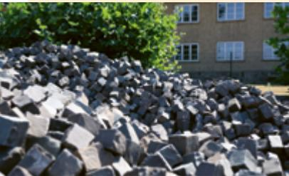
**11.000 m<sup>2</sup> Basaltpflastersteine** sind auf dem Gelände verlegt. Ca. 1.000 m<sup>2</sup> werden an Ort und Stelle in die Verkehrsfläche integriert. Die restlichen 10.000 m<sup>2</sup> werden aufgenommen, zwischengelagert und später in öffentlichen Flächen wieder eingebaut.
